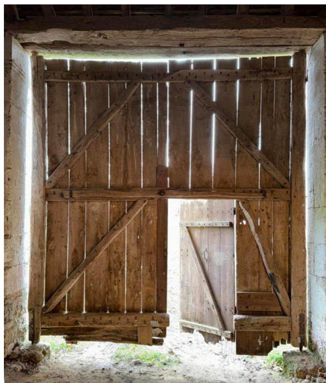
IMAGE 2 – Vue depuis l'intérieur, en position fermée ; on remarque : le fléau horizontal ; et les gonds, en haut en bois et en bas en métal dans les pierres
