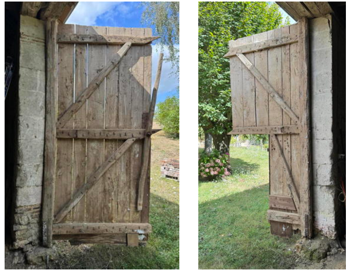
IMAGE 5 – Les portes en position ouvertes vers l'extérieur
