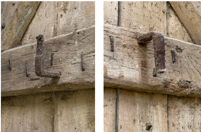
IMAGE 4 – Détail des crochets de retenue du fléau, et des clous forgés
