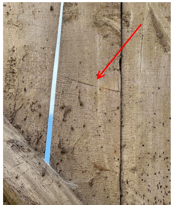
IMAGE 6 – Détail montrant les traces du sciage en long : à la rencontre des deux sciages en bout subsiste le petit triangle qui a éclaté
